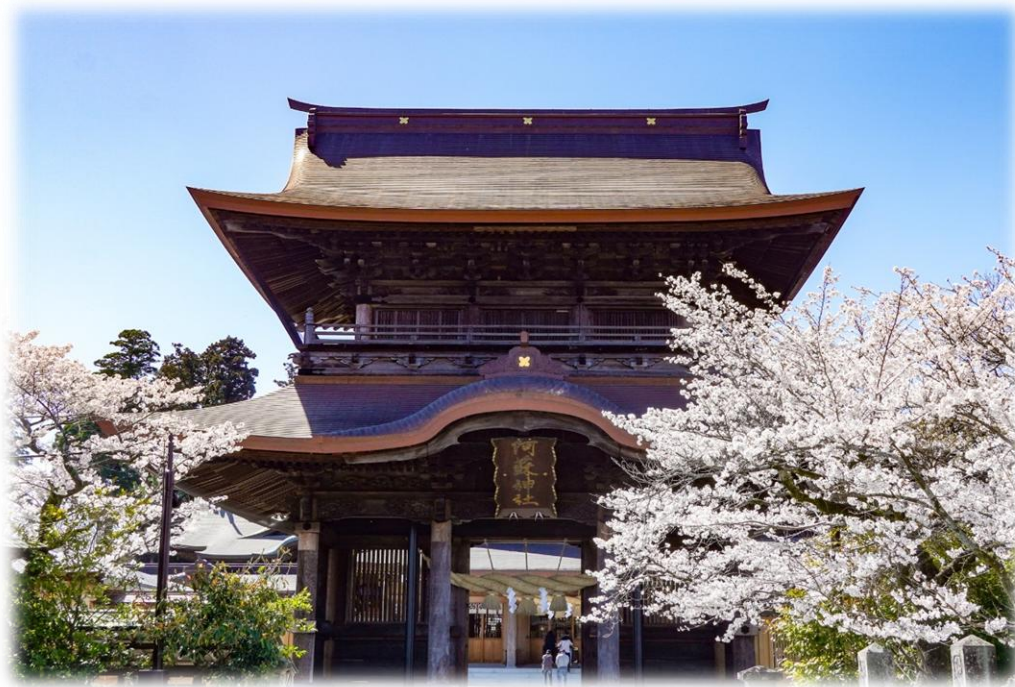
修復された楼門（国の重要文化財）
