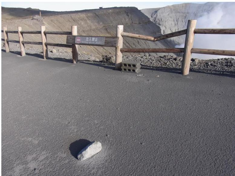
噴石により破損した防護柵（B-2ゾーン）
