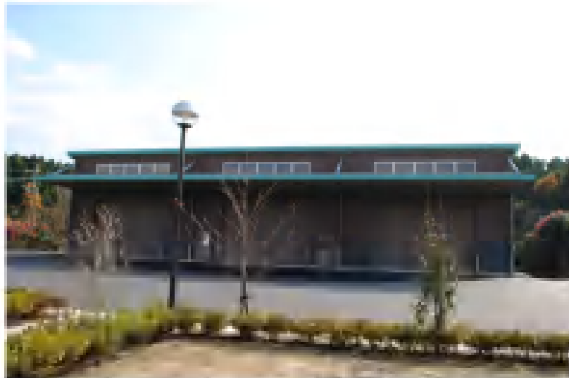
ストックヤード棟 外部 北面
