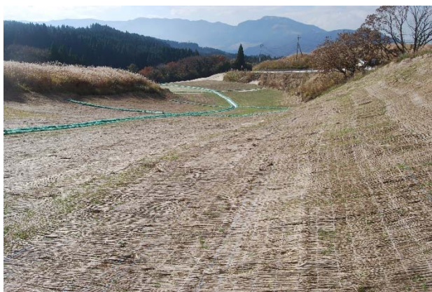
残土で埋め立てられた広場②
