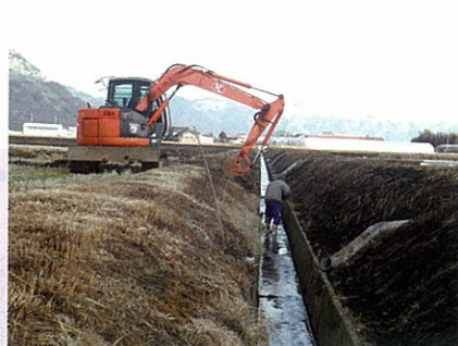
排水路畦畔の補修
