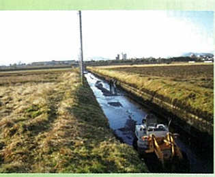
排水路の掘削
