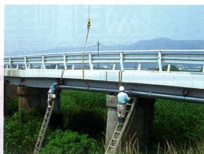
パイプラインの改修
