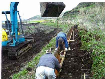
用水路の改修
