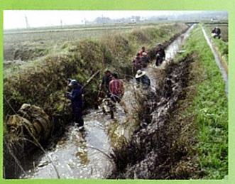
用排水路の泥上げ
