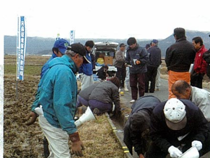
補修技術の研修（目地詰め講習会）
