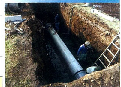
破損施設の改修(パイプライン)
