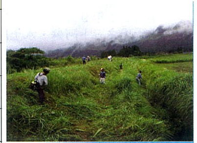
排水路畦畔の補修
