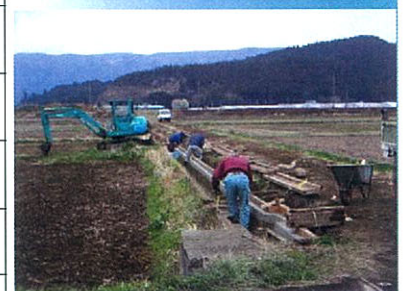
破損施設の改修(水路)
