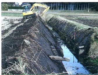
排水路畦畔の補修
