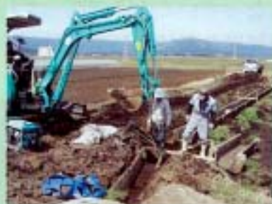
用水路の改修 (工区)
