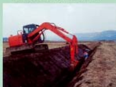
排水路畦畔の補修 (工区)
