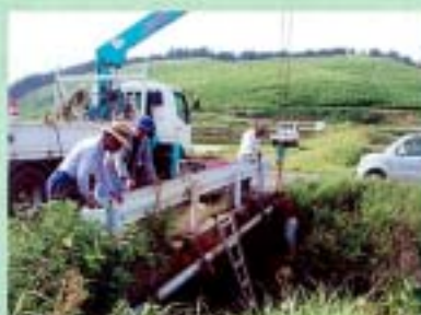
パイプラインの改修 (工区)
