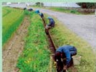
目地塗り作業 (工区)
