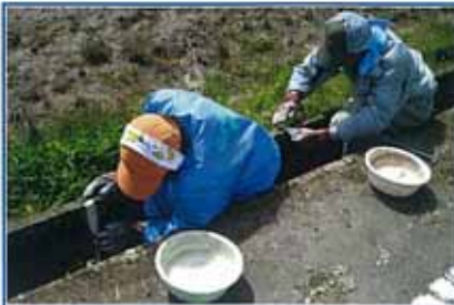
↑ 目地の補修 ・用排水路の目地補修
