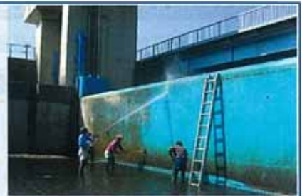
↑ 施設の保守管理の徹底 ・ゲートの清掃・塗装 ・パイプライン等の塗装等
