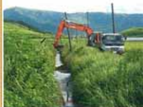
↑河川掘削 ・排水路の掘削
